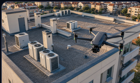
REVISIÓN VISUAL AÉREA CUBIERTA TÉCNICA Y CLIMATIZACIÓN
