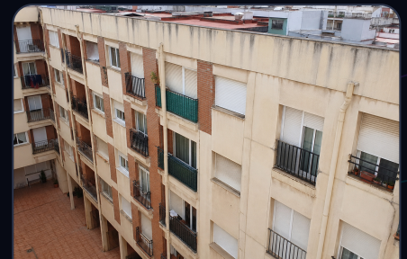
SEGUIMIENTO PERIÓDICO FACHADAS, PATIOS Y BAJANTES
