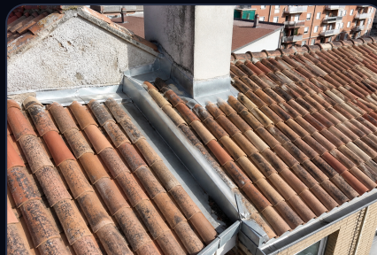
LOCALIZACIÓN VISUAL ENCUENTROS, CANALONES Y SELLADOS
